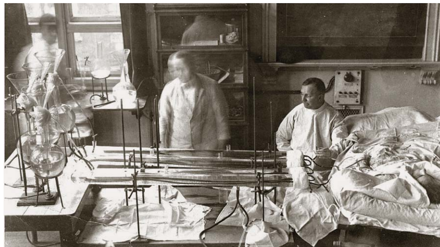
Abb. 1: Blutwäsche im damaligen Hörsaal der Medizinischen Klinik Gießen (1926): Rechts am Bett der urämischen Patientin sitzt Georg Haas und bedient ein T-förmiges Rohrstück, das als Luftblasen- und Gerinnselfänger fungiert. In der Mitte beobachtet sein Assistent Georg Balser die Funktion der Schlauchniere. Die Blutwäsche wurde mit Unterstützung des Chirurgen Fritz von der Hütten, der den vaskulären Zugang (A. radialis/V. cubiti) legte, und des Pflegers August Trinkaus durchgeführt.
