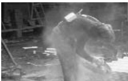
**Abb.2: Junger Dachdecker beim Flexen von Asbestzementplatten, Frankfurt/Main, 1979.**
