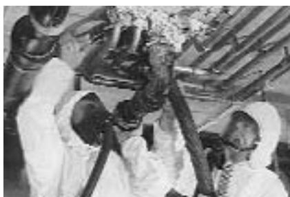
**Abb. 3: Entfernung von Spritzasbestisolierungen unter strengen Arbeitsschutzvorkehrungen, 1999.**
