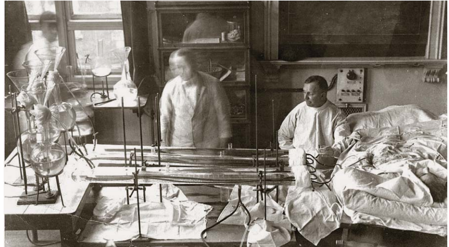
Abb. 1: Blutwäsche im damaligen Hörsaal der Medizinischen Klinik Gießen (1926): Rechts am Bett der urämischen Patientin sitzt Georg Haas und bedient ein T-förmiges Rohrstück, das als Luftblasen- und Gerinnselfänger fungiert. In der Mitte beobachtet sein Assistent Georg Balsler die Funktion der Schlauchniere. Die Blutwäsche wurde mit Unterstützung des Chirurgen Fritz von der Hütten, der den vaskulären Zugang (A. radialis/V. cubiti) legte, und des Pflegers August Trinkaus durchgeführt.
