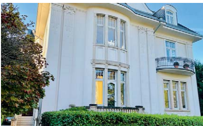
Neue Büros im Erdgeschoss einer Gründerzeitvilla, Baujahr um 1900.
