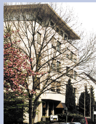
Gebäude der Landesärztekammer in Frankfurt
