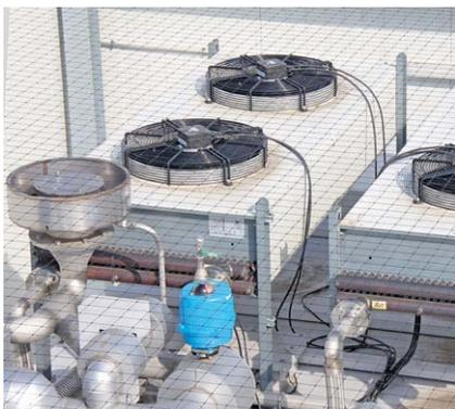
Auf dem Dach erzeugt eine Brennstoffzelle (vorn im Bild) aus Erdgas (oder später auch Wasserstoff) eine elektrische Leistung von 100 Kilowatt. Sie deckt gut 40 % des Wärmebedarfs für die Trinkwarmwassererzeugung.
